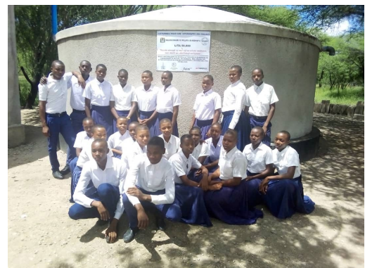
Kuva 7: Sadevesisäiliö ja oppilaat koulun pihalla.
