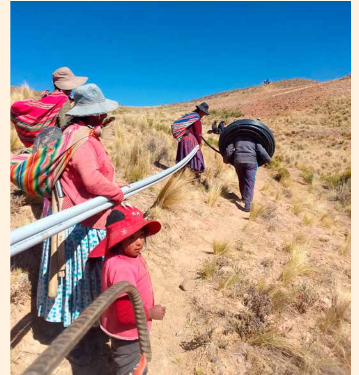
Byborna är med och bygger vattensystem.
