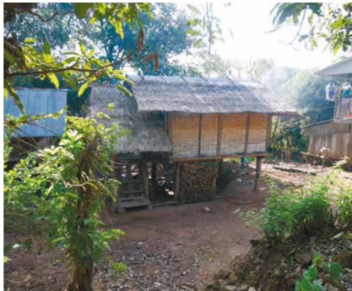
Mormor Yai Miis hus är byggt på traditionellt sätt av bambu. Alla hus byggs på pålar så att regnvattnet inte strömmar in och så att ormar och andra kräldjur, grisar och hönar inte kommer in i huset.
